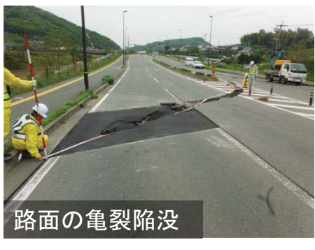
路面の亀裂陥没
