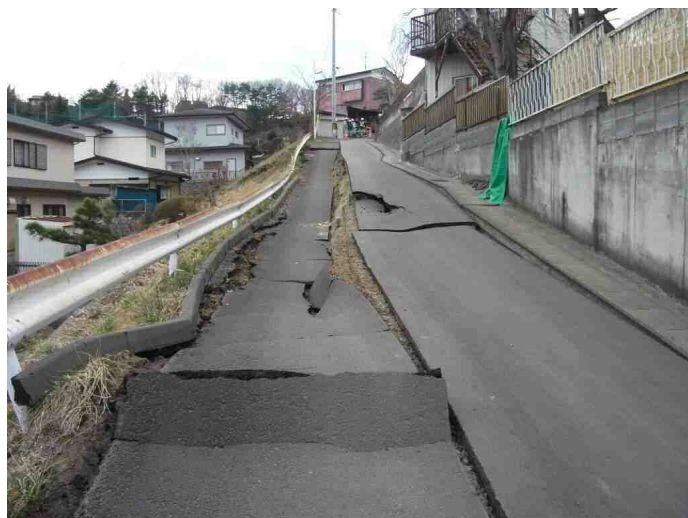
路面の沈下や段差
