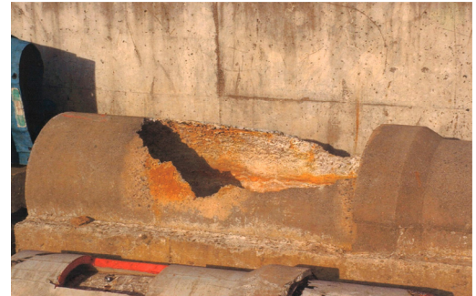
腐食による破損
