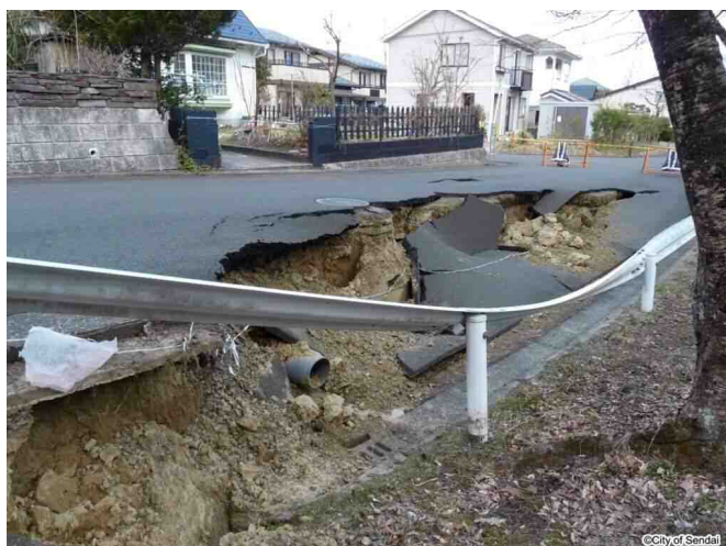
道路法面の崩壊
