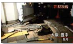
2013年:大阪府豊中市老朽下水施設が原因の陥没小児を抱いた女性が転落して怪我
