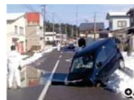
2017年:新潟県出雲崎町橋梁基礎部分の土砂流出が原因で陥没、負傷者が緊急搬送される
