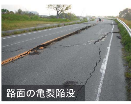
路面の亀裂陥没
