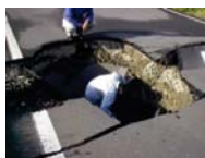
2003年:北海道白老町十勝沖地震で生じた陥没
