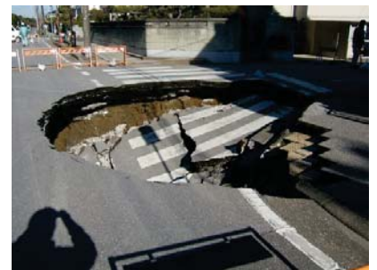
2011年3月11日:千葉県内東日本大震災の直後に、老朽した下水管に起因する空洞箇所での路面陥没が発生
