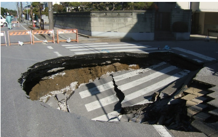
東日本大震災(千葉県内): 3/11の翌朝に撮影された投稿写真 原因は下水からの吸出し
