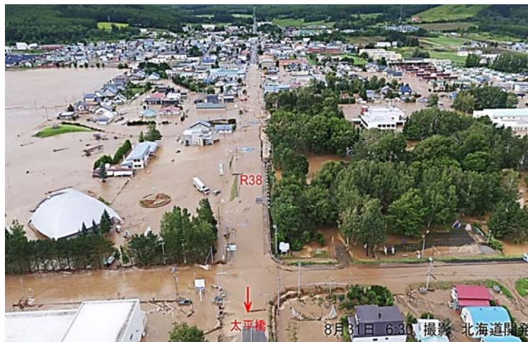
空知川上流（南富良野町） 堤防決壊
