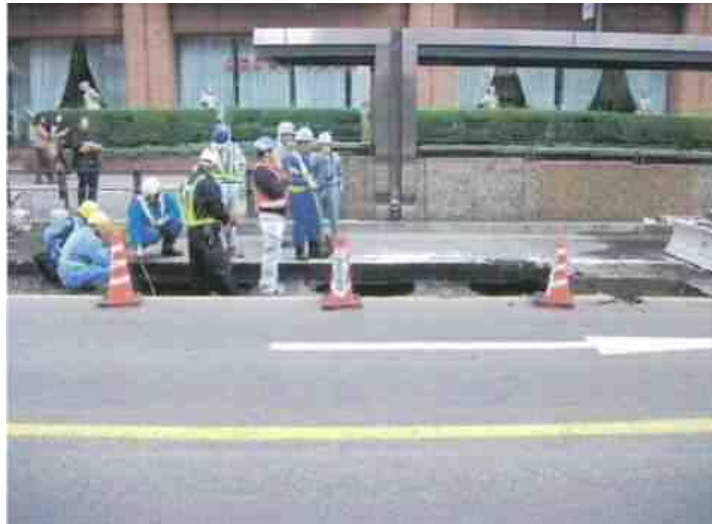
路面下の空洞
