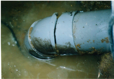
塩ビ管継手部のクラック
