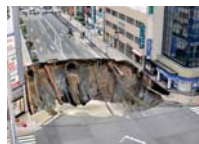
2016年:福岡市博多駅前地下鉄工事による陥没
