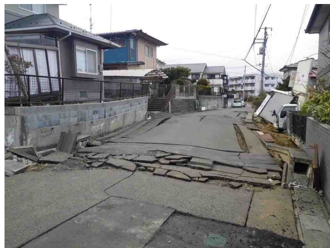
路面の亀裂
