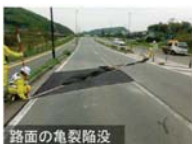
2016年:熊本県熊本市熊本地震で発生した陥没
