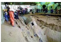
1990年:東京都台東区(御徒町)地下鉄工事による陥没
