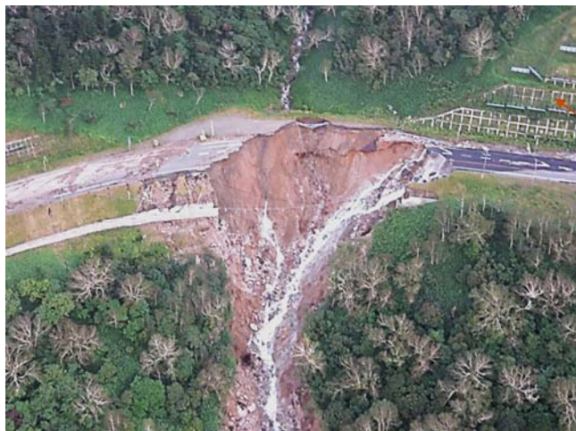
国道274号日勝峠（清水町） 土砂崩れ
