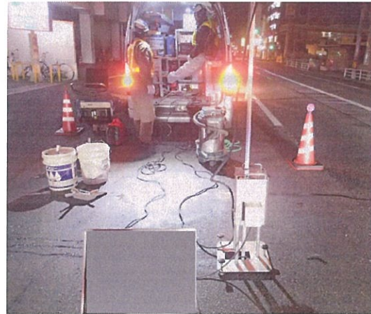
<写真 5.2-3>スコープ調査状況
