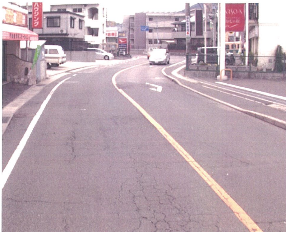
<写真 6-1>MCI3 程度の路面
