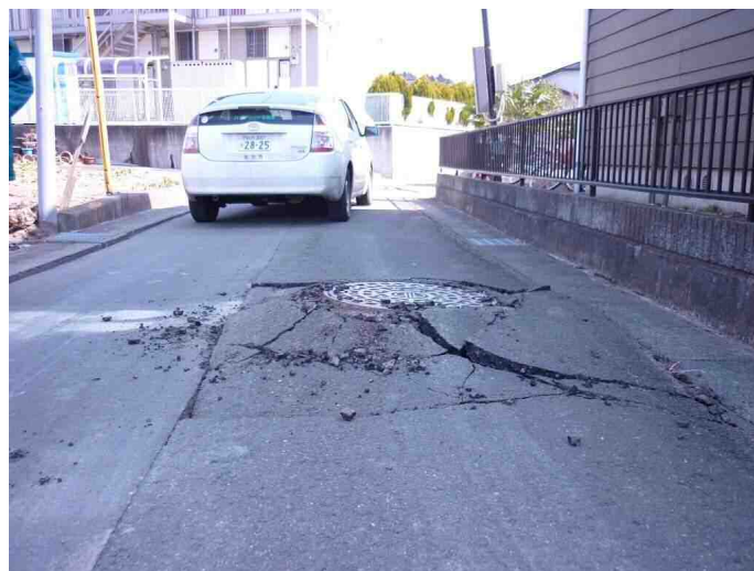
マンホールの隆起
