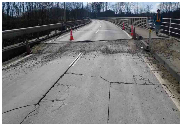
橋梁背面の段差
