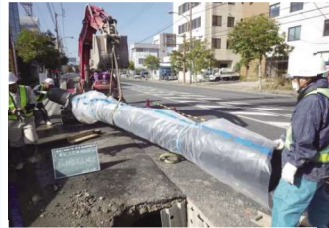
耐震管への布設替
