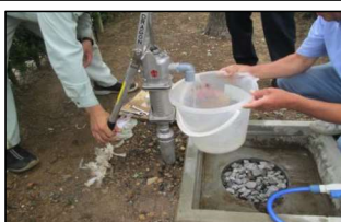
高知市城西中学校に井戸を設置
