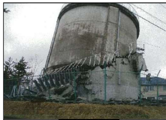
配水池の損壊
