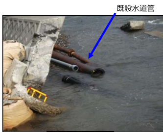
管路の抜け出し
