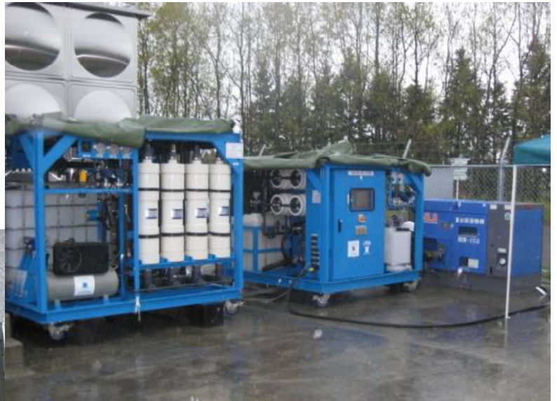
<可搬式浄水装置の設置状況> (4月21日 10時20分撮影)
