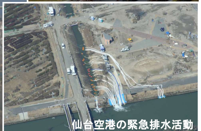
【全国に配備している排水ポンプ車を仙台空港に集中投入】
