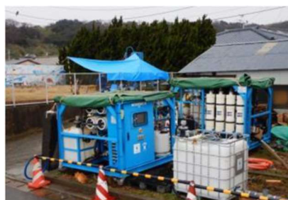
装置本体設置完了
