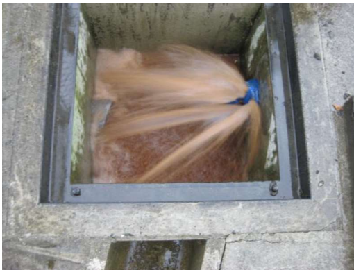
<上川井野配水池の混濁状況> (4月21日 8時33分撮影)
