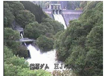
緊急放流の様子(藤原ダム)
