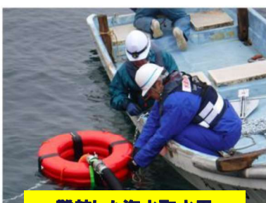
離航した海水取水用ポンプ設置状況
