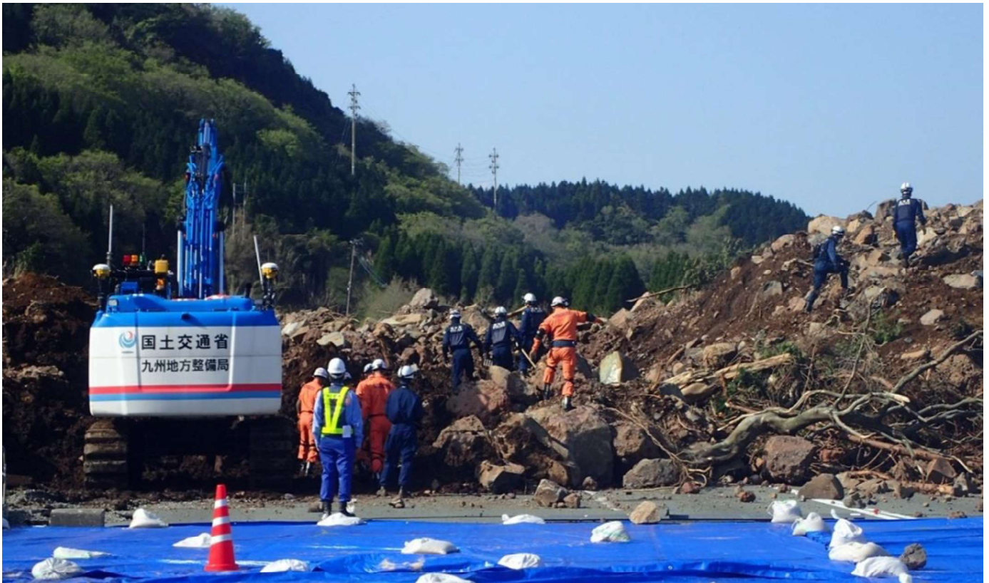
【遠隔操縦の重機が搜索を支援(南阿蘇村)】
