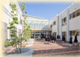
老朽化した施設を長寿命化改修を行い、安全性を向上させるとともに教育内容の変化に対応
