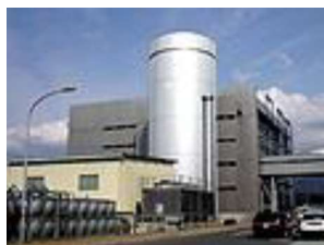
冷水蓄熱槽例
