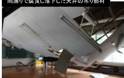
雨漏りで腐食し落下した天井の吊り部材
