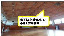
天井等落下防止対策
