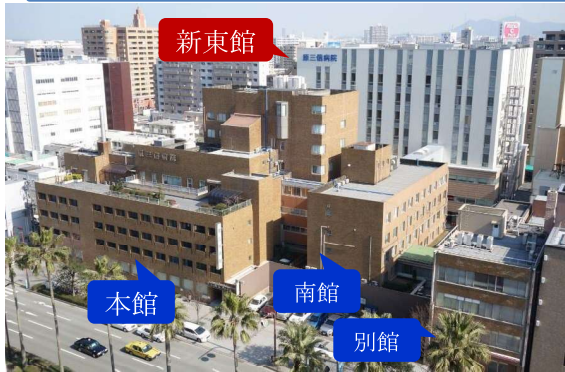
建物外観(新東館コージェネ設置)
