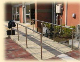
エレベーターやスロープの設置等のバリアフリー化
