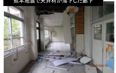
熊本地震で天井材が落下した廊下
