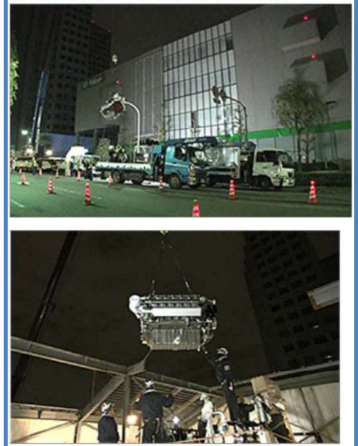
コージェネをオフィス棟の屋上に搬入・設置
