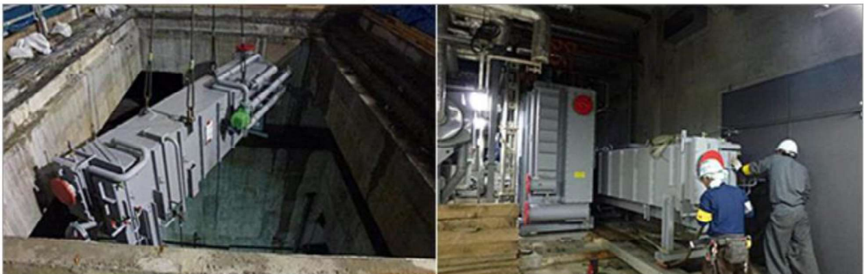
排熱投入型吸収式冷凍機を分割して搬入・設置
