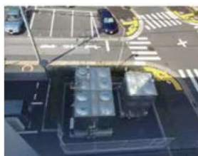
大容量の受水槽
