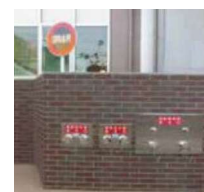
道路脇ホース接続口
