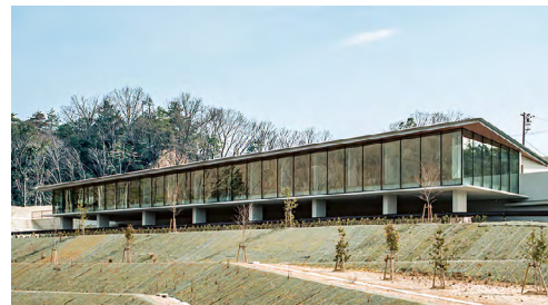
ガラス面と軽快な屋根が印象的な建物外観
