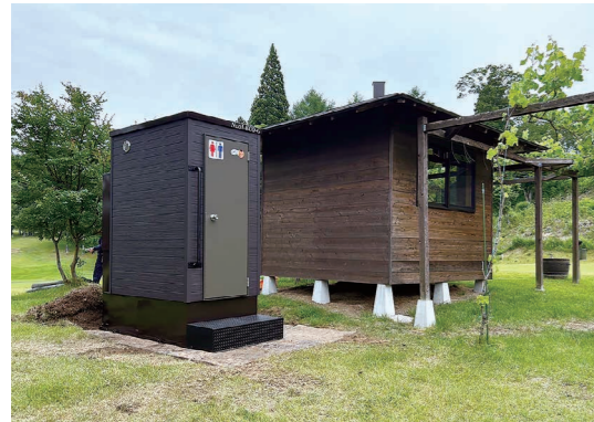
ゴルフ場に設置されたミネラルイオントイレ
