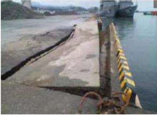
岸壁の破損
