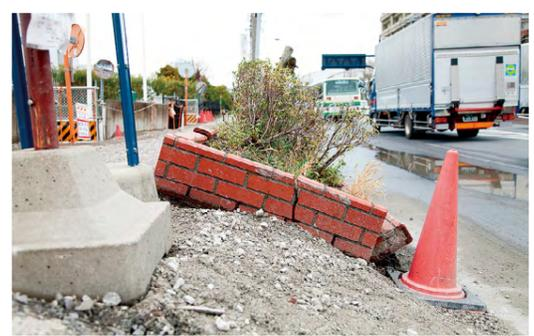
液状化による道路の被害例
