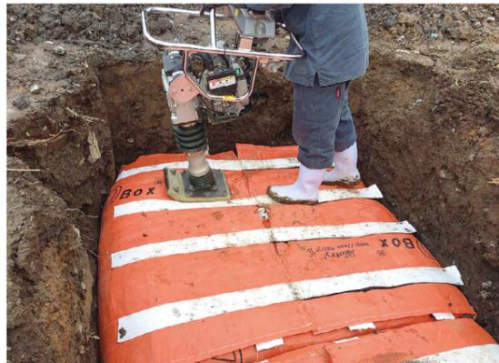
D・BOX-LS（形状保持型吊上げ式直方体バッグ）。内部に拘束バンドを備えた袋に土を入れ、袋の上から圧力をかけることで固化させる。
