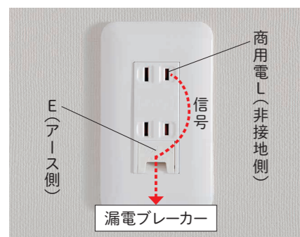
揺れを感知し、漏電ブレーカーに信号を流す
