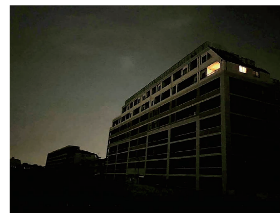
2022年3月16日、首都圏210万世帯が停電した日の実際の写真。tsuitaのある住戸は明かりがともっている
